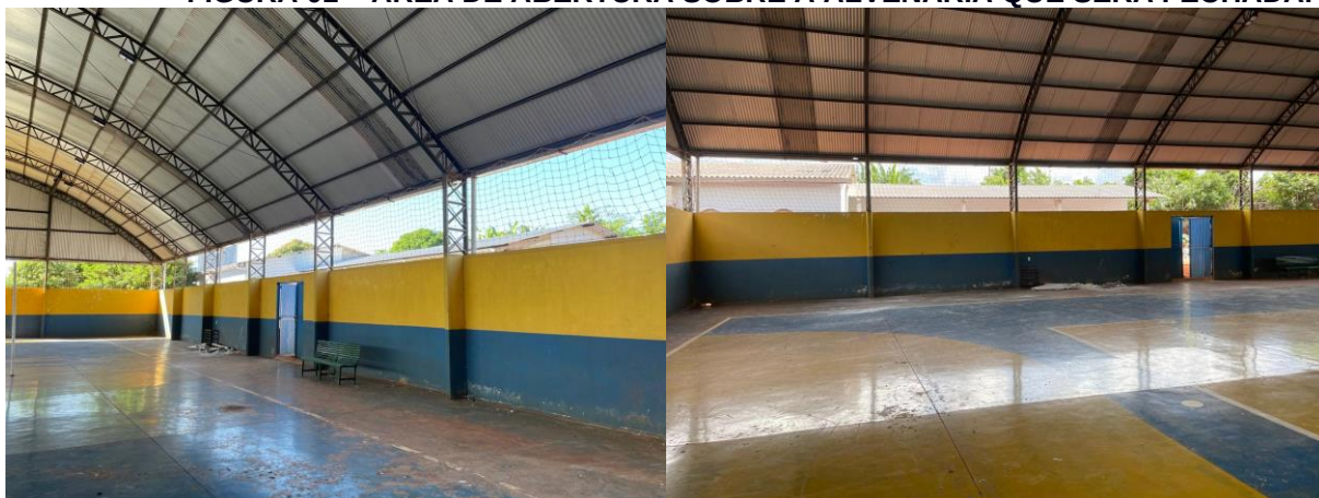
FIGURA 01 – ÁREA DE ABERTURA SOBRE A ALVENARIA QUE SERÁ FECHADA.
