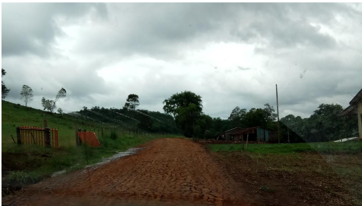
Foto 02 – Final do trecho (estaca 236)
